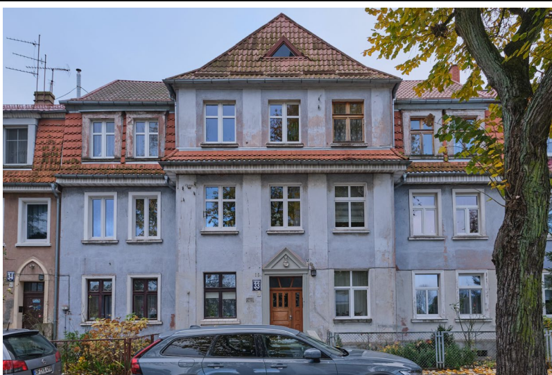
Widok na elewację frontową od północy
