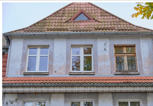
Widok na szczyt ryzalitu
