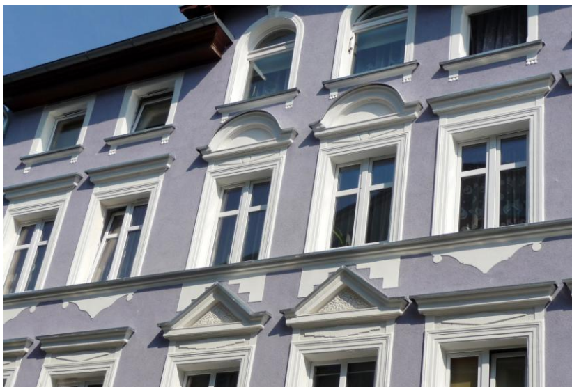
Otwory okienne w elewacji zachodniej
