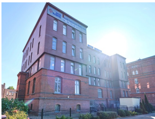
Widok ogólny od płn.-zachodu
