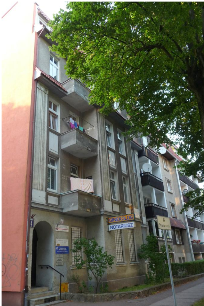
Widok budynku od południa
