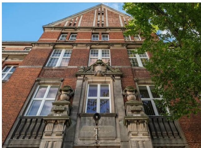
Fasada, ryzalit środkowy, fragment górnej części portalu
