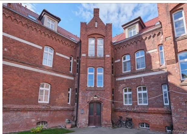
Fragment elewacji dziedzińcowej z narożnym ryzalitem
