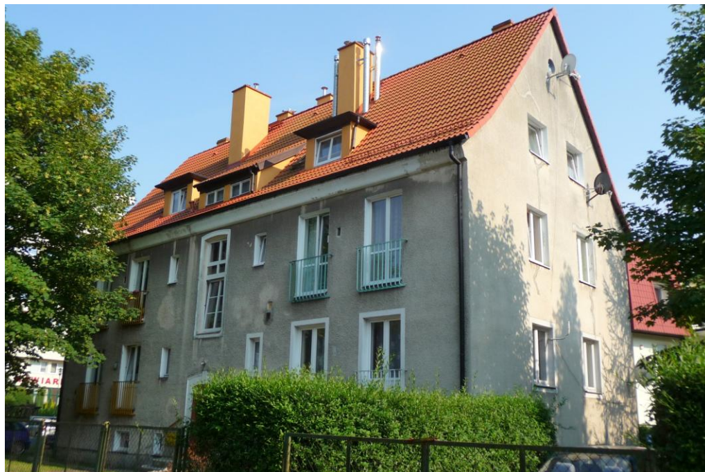
Widok budynku od północnego-zachodu
