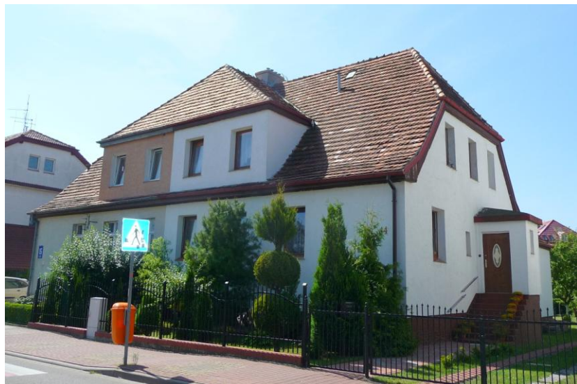
Widok budynku od północnego-wschodu
