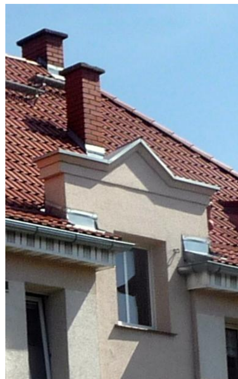
Murek attykowy w elewacji południowo-zachodniej
