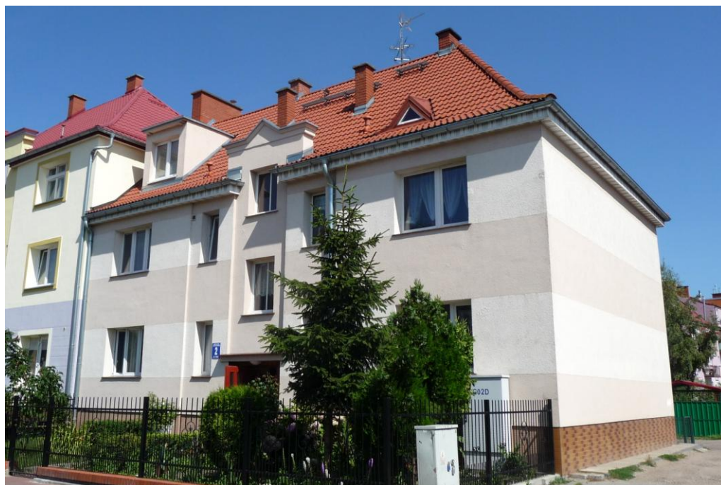
Widok budynku od południowo-zachodu
