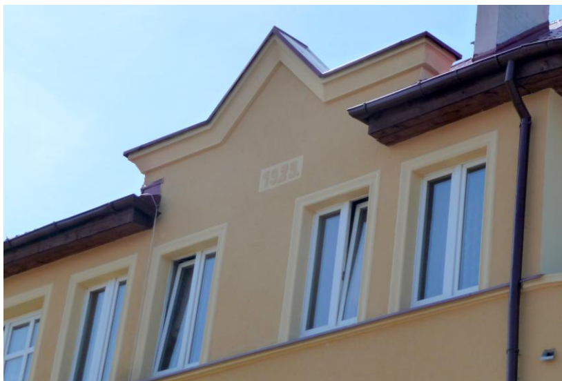
Szczyt elewacji północnej
