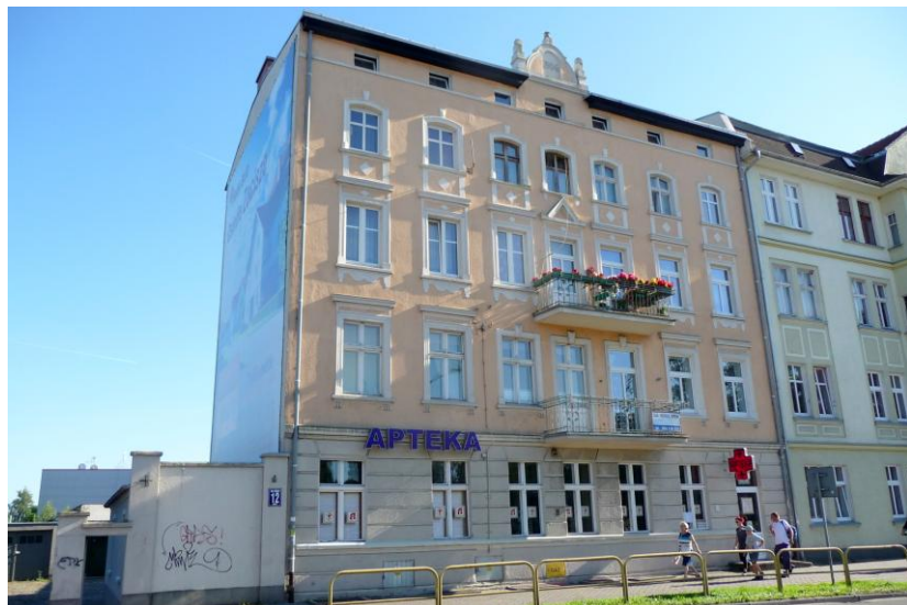
Widok budynku od północy
