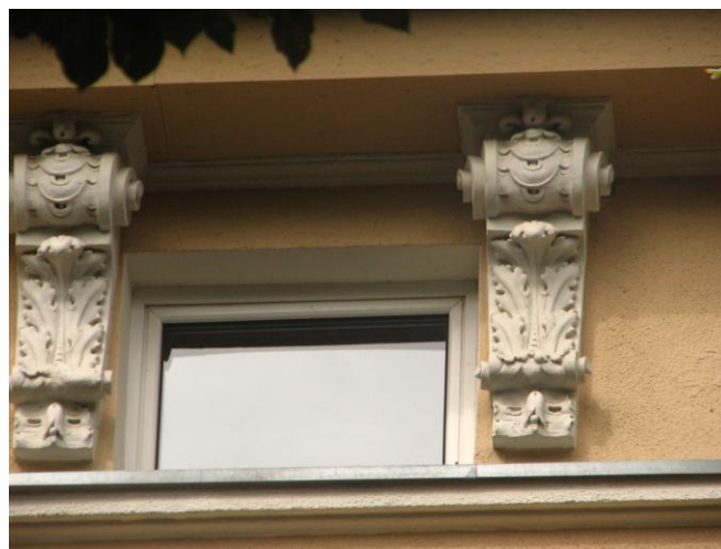
Konsolki podtrzymujące gzyms w elewacji południowo-wschodniej
