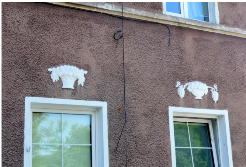
Detal w elewacji frontowej
