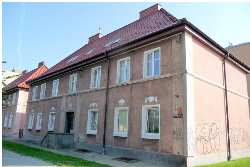
Widok budynku od północy
