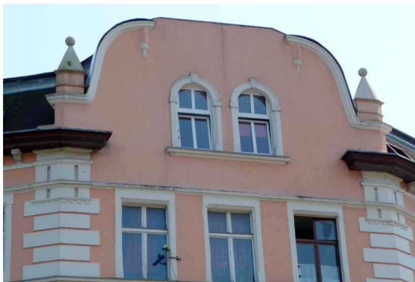
Otwory okienne w narożu budynku
