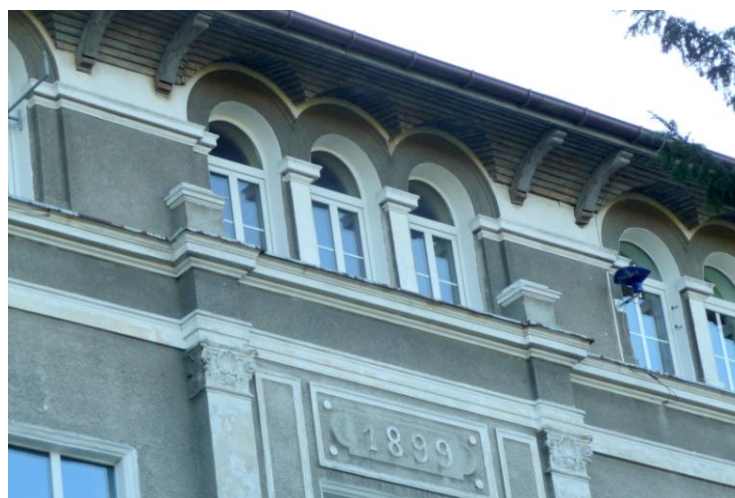
Otwory okienne w elewacji wschodniej skrzydła pd.
