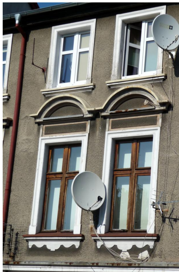
Otwory okienne w elewacji frontowej
