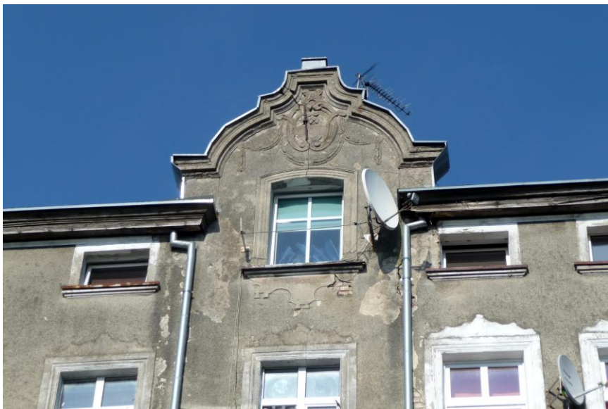
Szczyt facjaty w zachodniej połaci dachu
