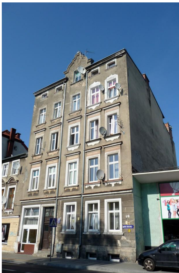
Widok budynku od południowo-zachodu
