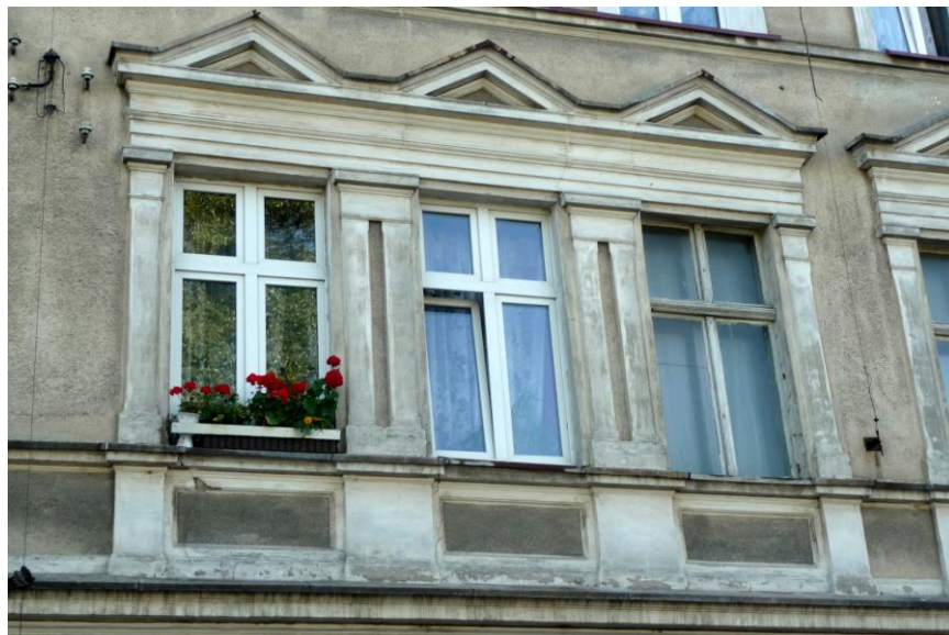
Otwory okienne elewacji frontowej
