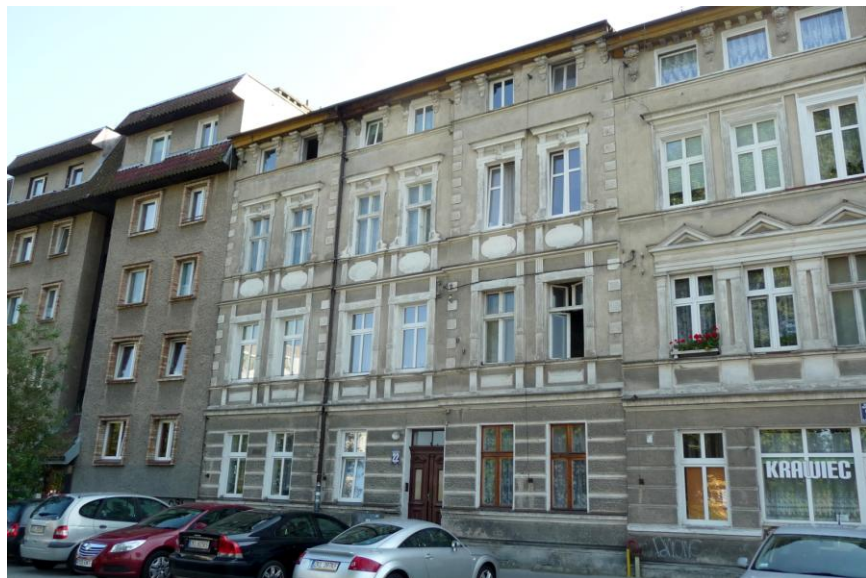
Widok budynku od północnego-wschodu
