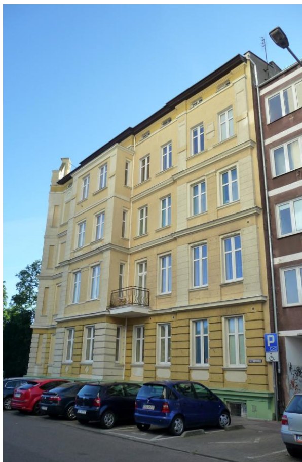
Widok budynku od wschodu
