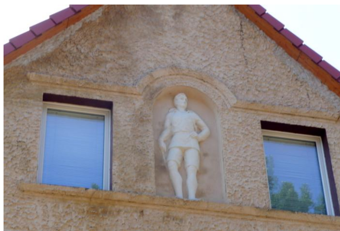
Figura w szczycie budynku
