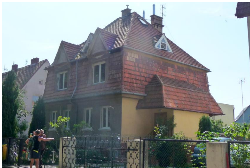
Widok budynku od północnego-zachodu
