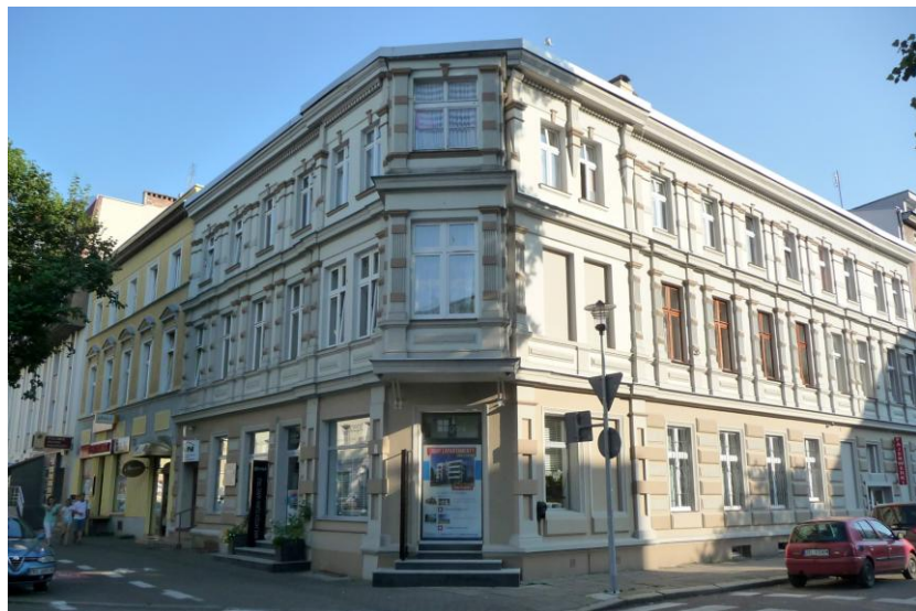
Widok budynku od północy
