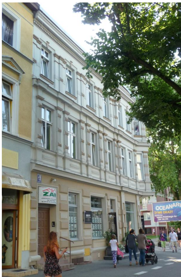
Widok budynku od północno-wschodu
