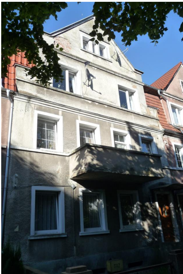
Widok budynku od południowego-zachodu
