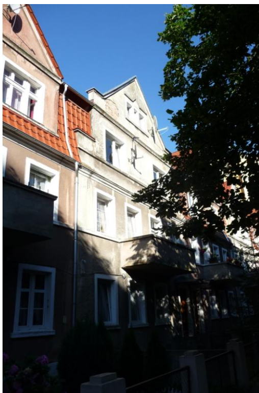
Widok budynku od południowego-zachodu
