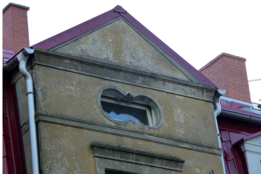
Szczyt ryzalitu klatki schodowej
