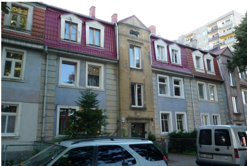
Widok budynku od północnego-wschodu
