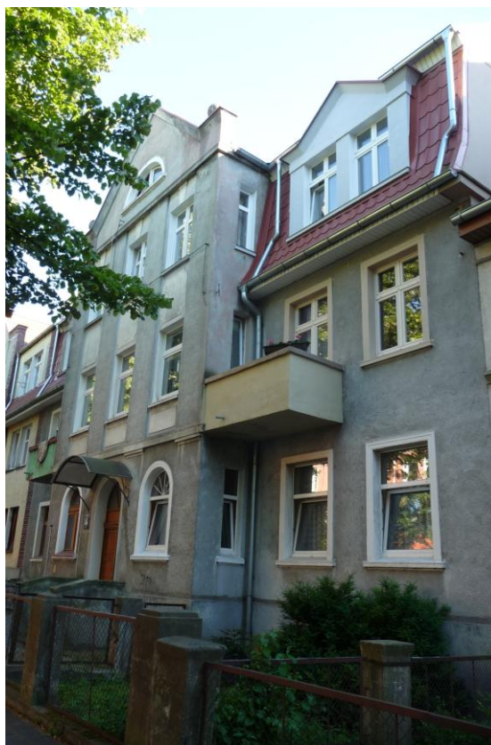
Widok budynku od północy
