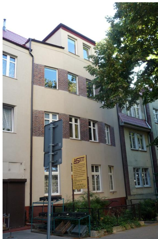
Widok budynku od północnego-wschodu
