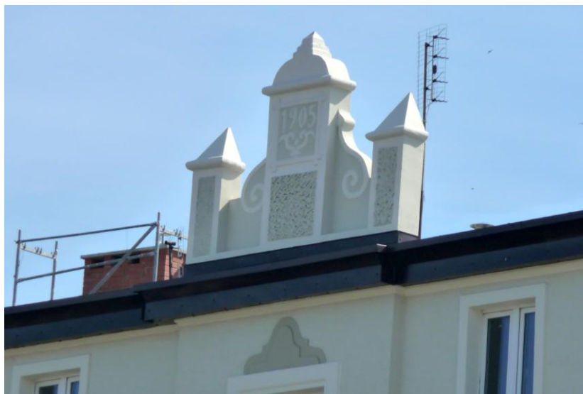
Szczyt ryzalitu elewacji frontowej
