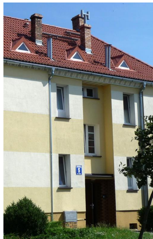
Część elewacji południowo-zachodniej
