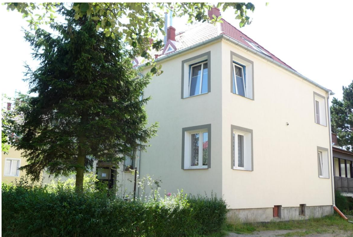
Widok budynku od północy
