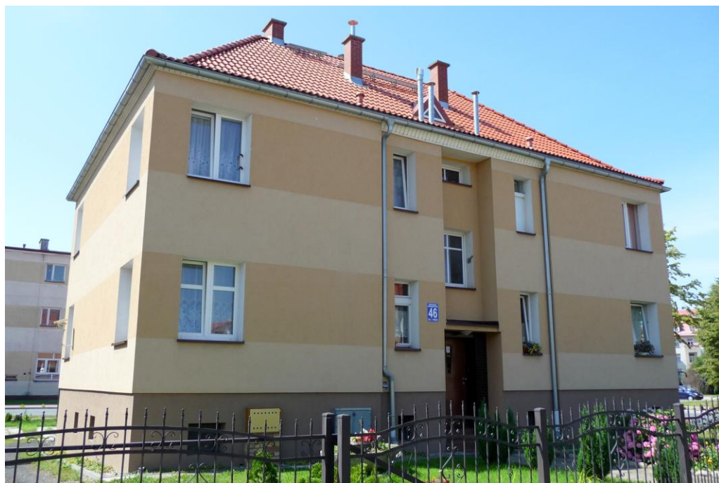
Widok budynku od wschodu
