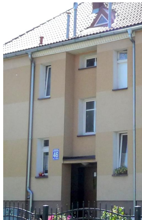
Część elewacji północno-wschodniej
