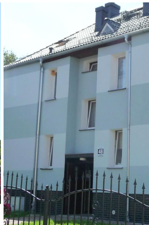
Część elewacji północno-wschodniej
