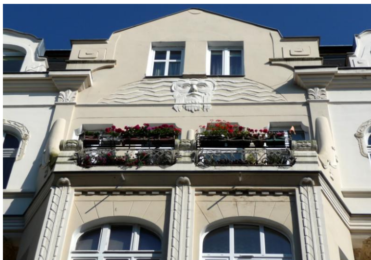
Balkon w elewacji północno-zachodniej
