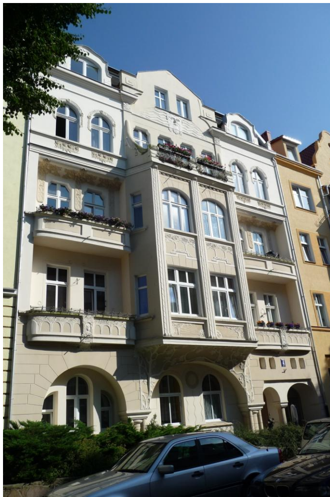
Widok budynku od północno-zachodu
