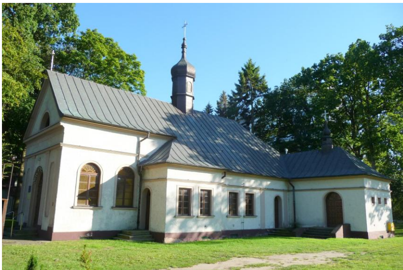
Widok budynku od północy
