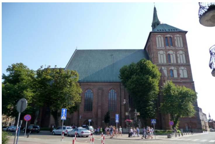
Widok budynku od północy
