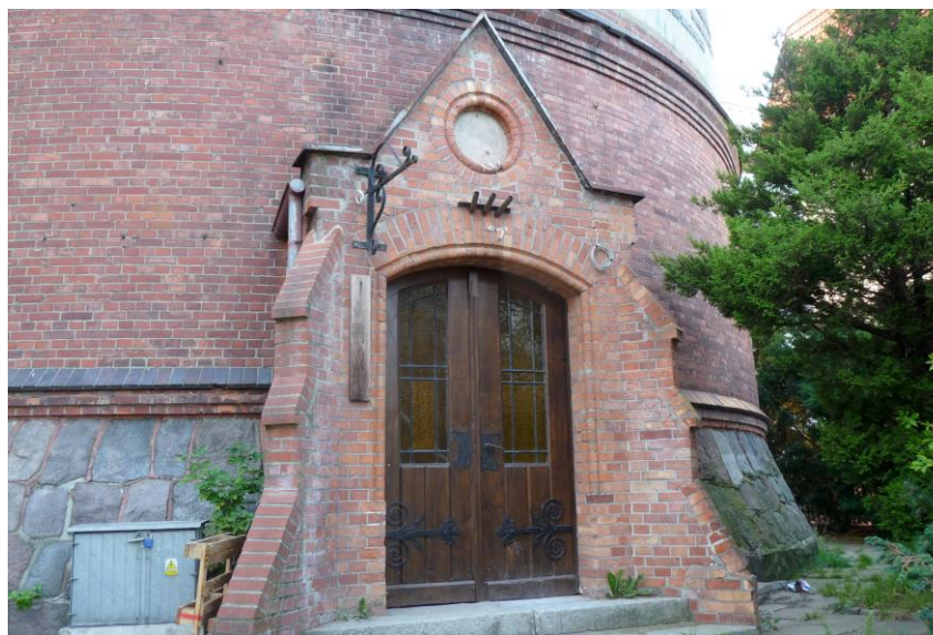
Portal drzwiowy, widok od południowego-wschodu
