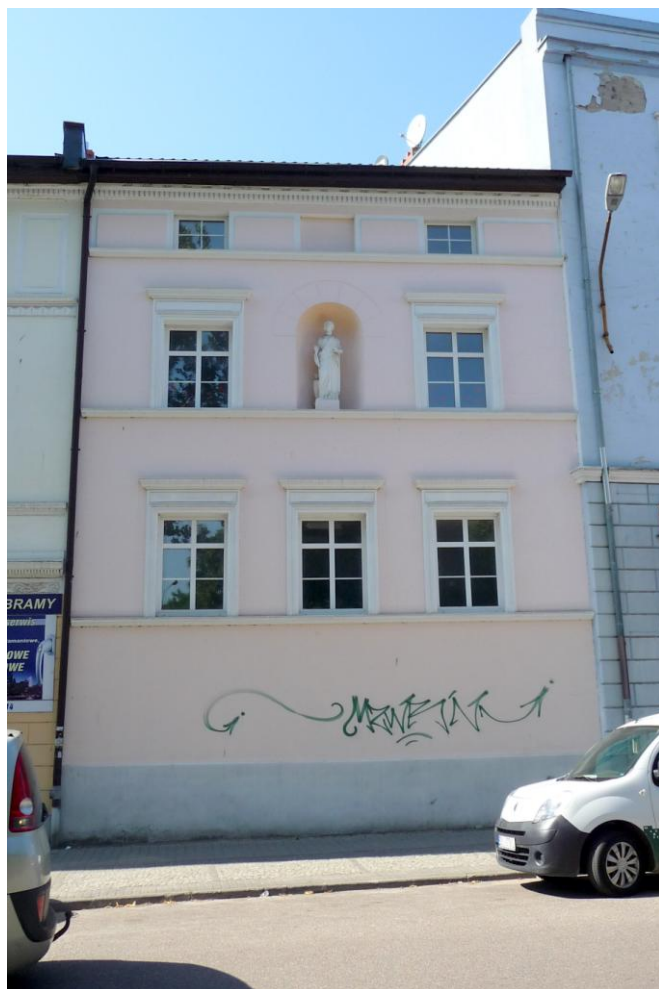
Widok budynku od południowego-wschodu
