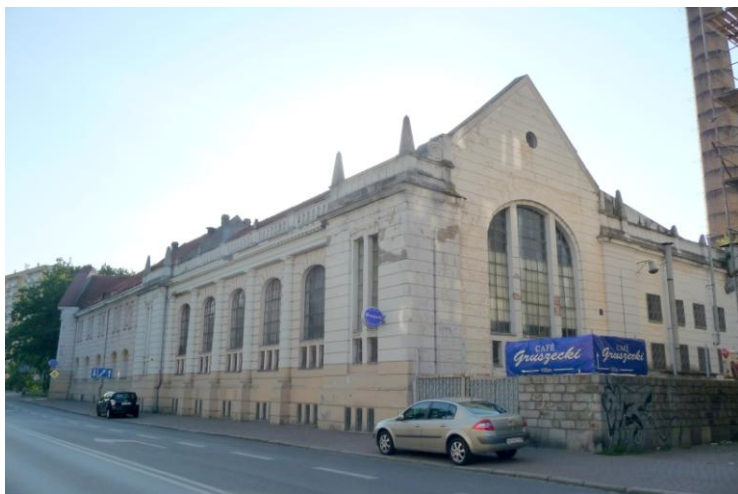
Widok budynku od wschodu
