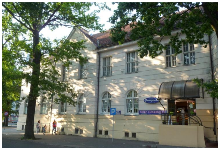
Widok budynku od południowo-zachodu
