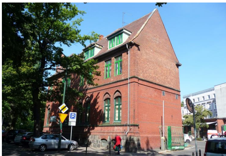
Widok budynku od południowego-zachodu
