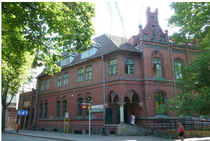
Widok budynku od północy
