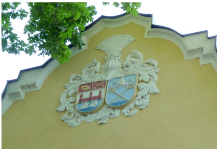
Szczyt elewacji północno-wschodniej
