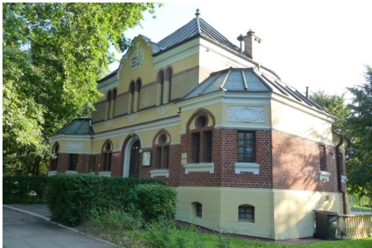
Widok budynku od północy
