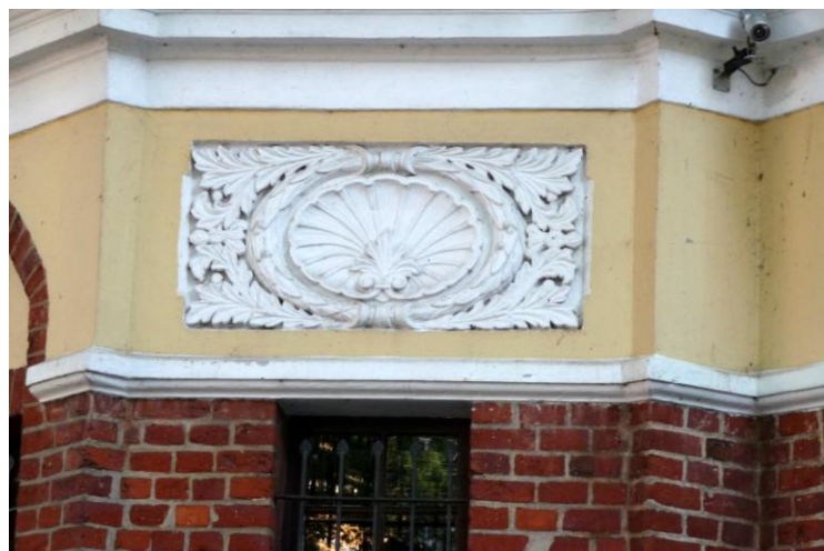
Płycina nad oknem północnego naroża budynku
