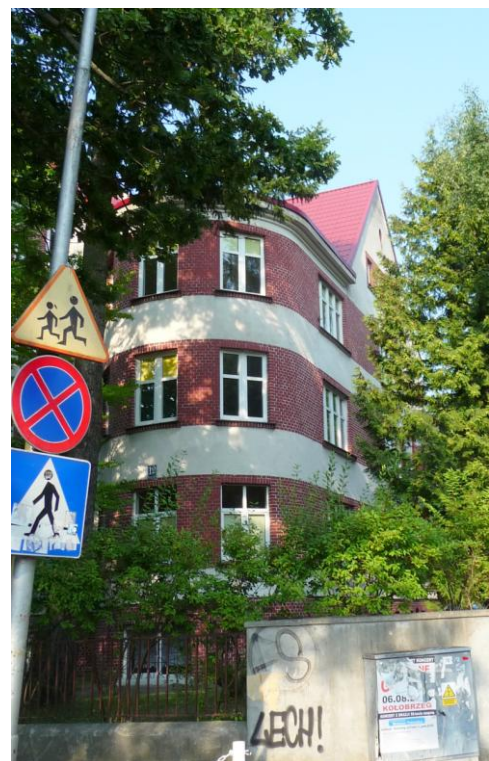
Ryzalit w południowo-zachodnim narożu budynku
