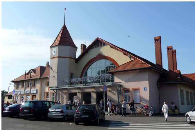
Widok budynku od południa
