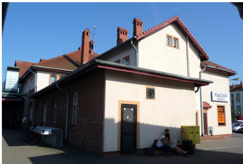
Widok budynku od północnego-zachodu
