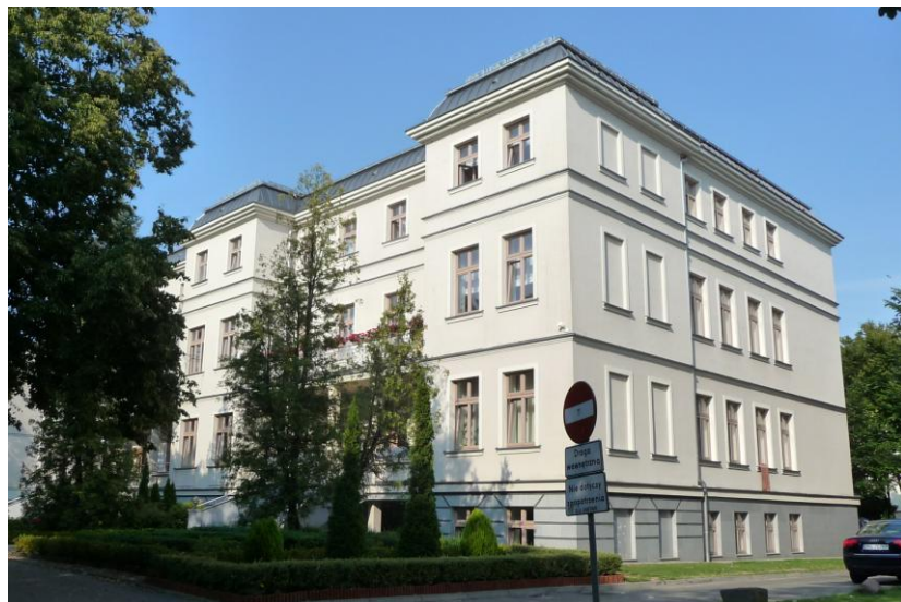
Widok budynku od południowego-zachodu
