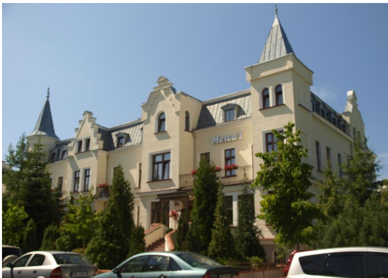
Widok budynku od północnego-wschodu
