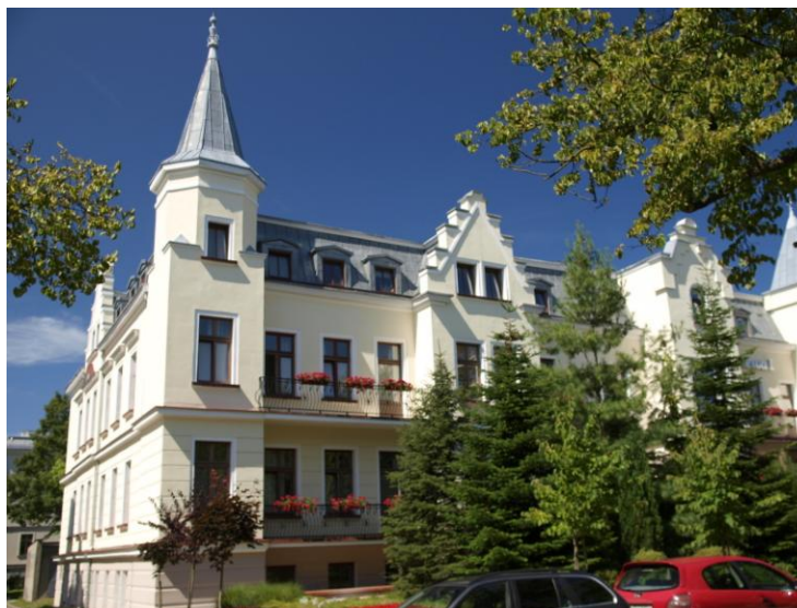
Widok budynku od południowego-wschodu
