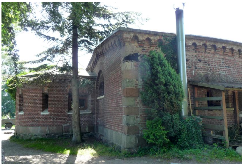
Widok budynku od północy
