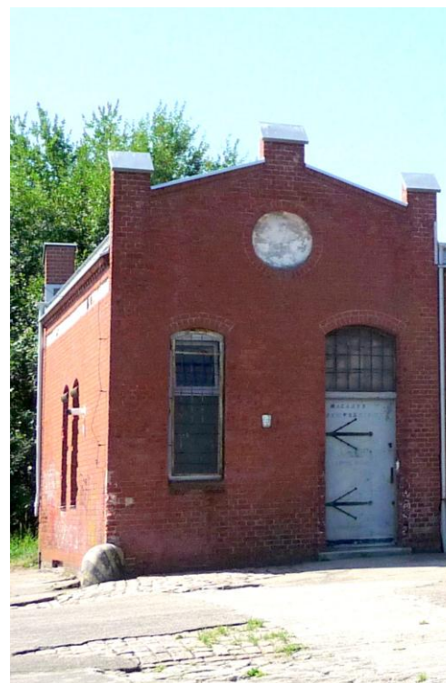
skrzydło południowe, widok od północnego-wschodu
