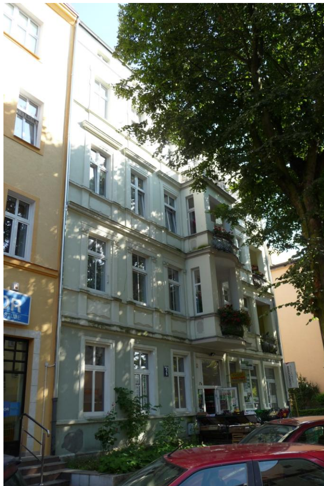
Widok budynku od północnego-zachodu
