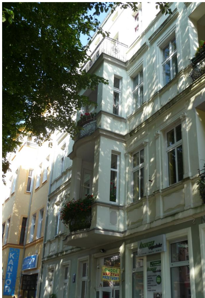
Wykusze elewacji północno-zachodniej
