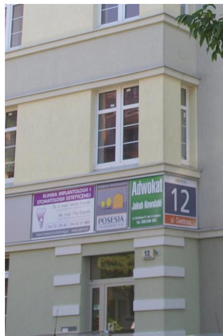
Otwory okienne w ryzalitu elewacji północno-wschodniej
