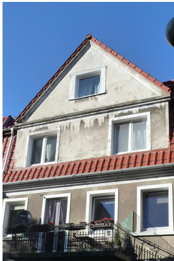
Facjata w frontowej połąci dachu
