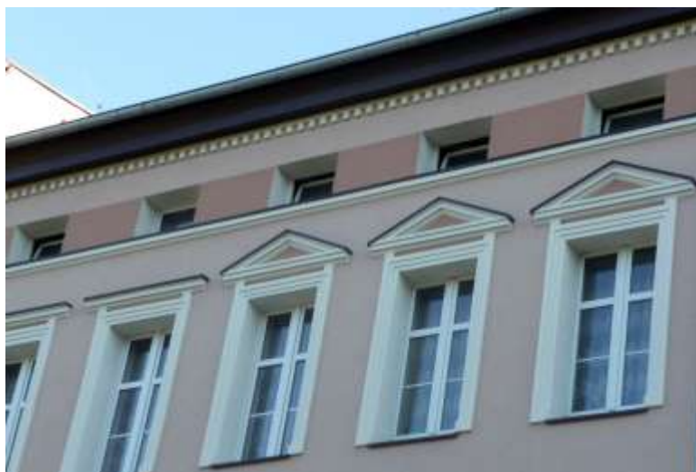
Otwory okienne elewacji frontowej
