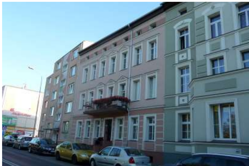
Widok budynku od północy
